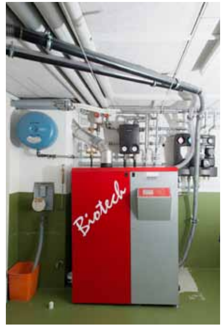
Der stufenlos regulierbare Pelletskessel moderner Ausprägung von Biotech.
