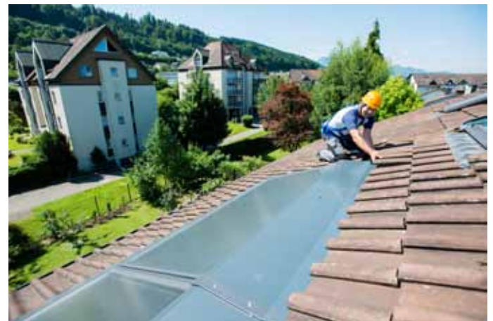
Montage der Kollektoren mit einer Fläche von total 5,47 m 2 .
