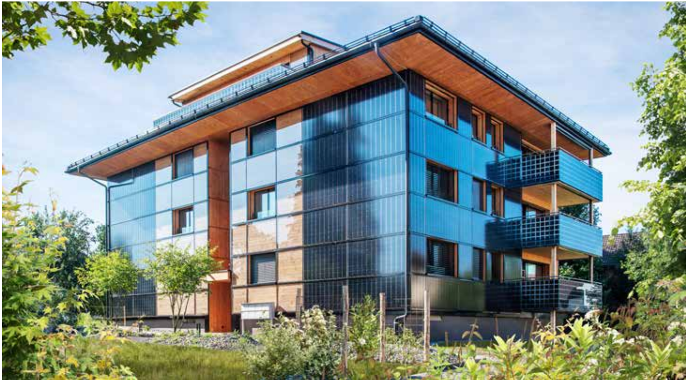
1 Das 315% NF Min.P/PlusEnergie-MFH produziert jährlich 78'000 kWh Solarstrom statt 137'700 kWh/a fossil-nukleare Energien zu verbrennen.
