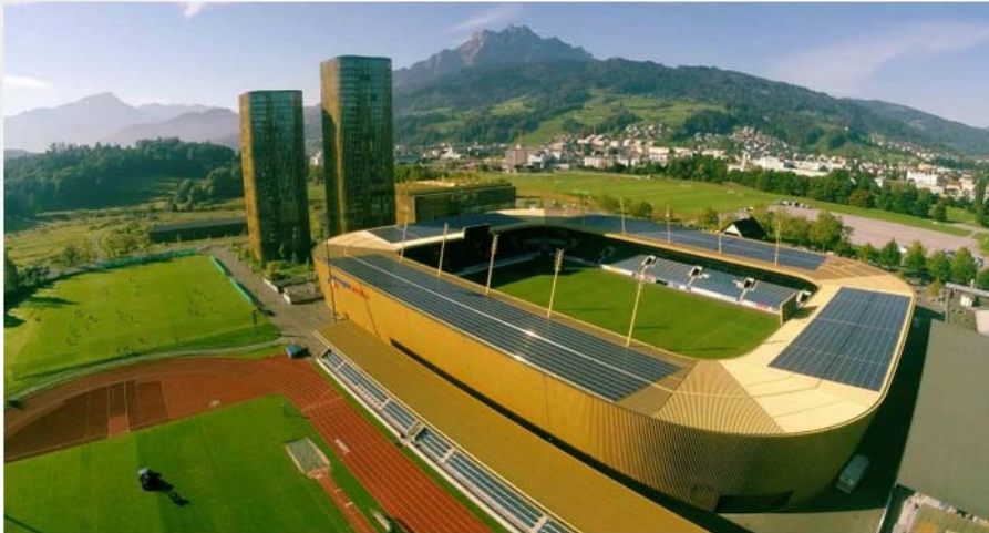
Die swissporarena gekrönt von einem Kraftwerk der Luzerner BE Netz
