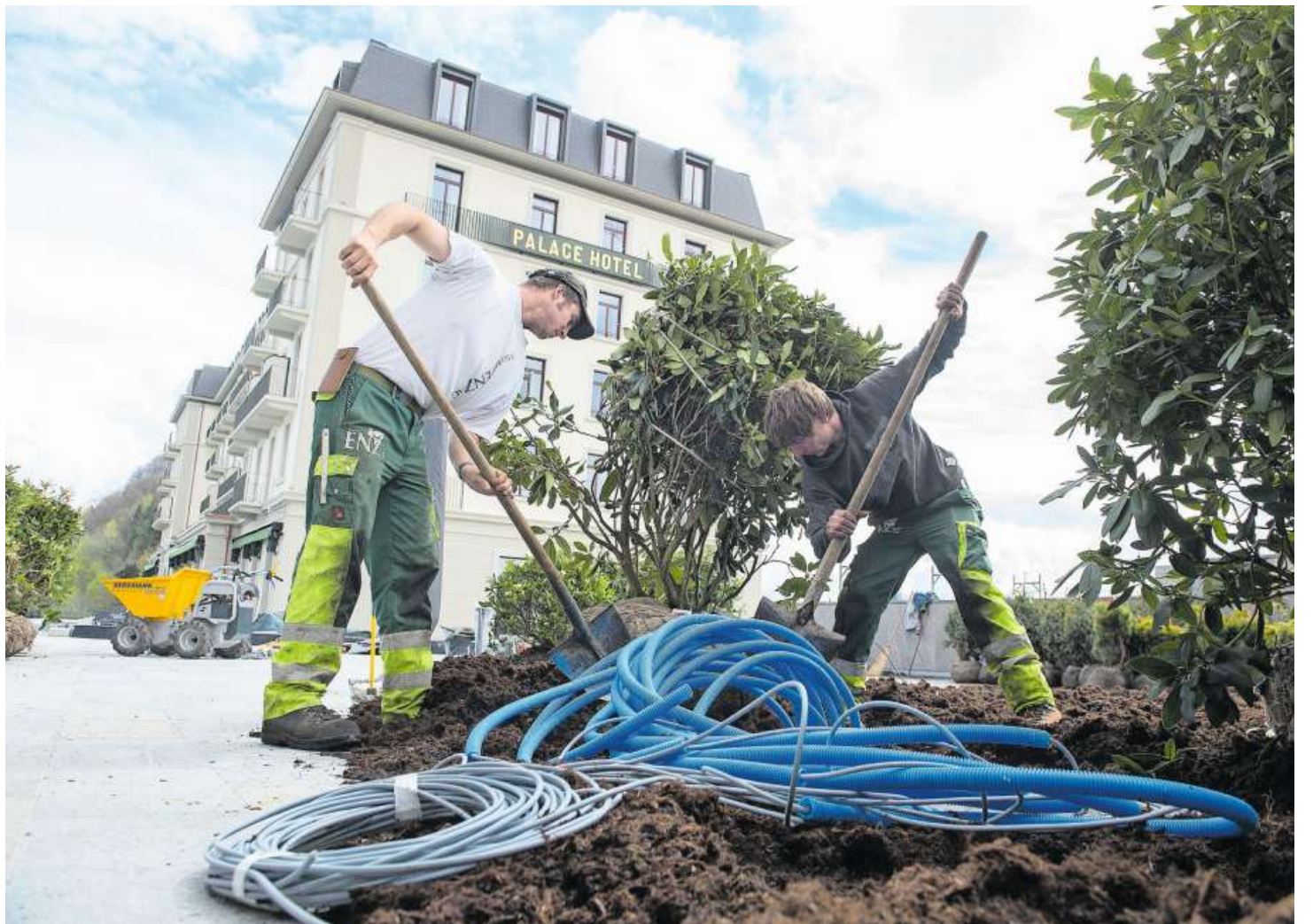
Endspurt beim Bau des Bürgenstock-Resorts.
