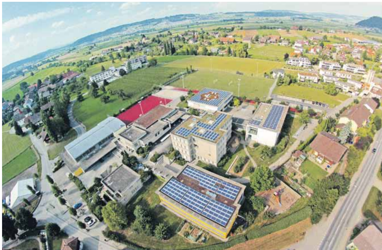
Vier der Ettiswiler Schulhausdächer produzieren seit Mitte August Strom. Verantwortlich dafür ist mit dem Ettiswiler Stefan Affolter ein privater Investor. Foto zvg
