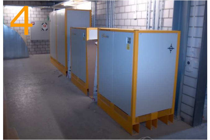
4 / Wechselrichter von Sputnik, Biel SolarMax 300C/100C
