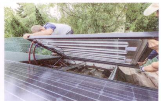
Eines der 230 Hybridmodule wird platziert. Blick auf die Unterseite.
