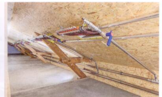
Anschlüsse Hybridmodule an Sammelleitung nach dem Tichelmann-Prinzip.
