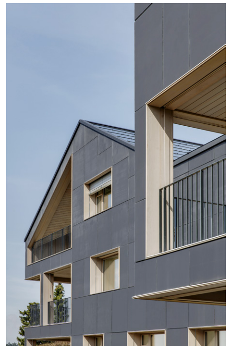
Fassaden-Anlage energieautarkes Mehrfamilienhaus, Brütten. (Bild: zVg)
