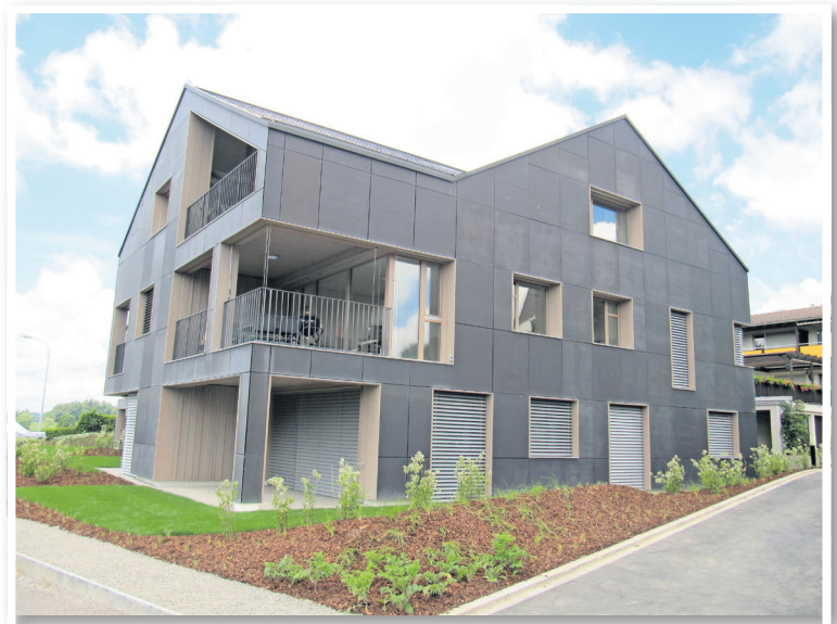
Erstes energieautarkes MFH in Brütten mit anthrazitfarbenen Modulen.
