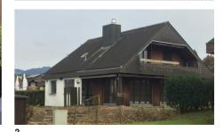
Die 29 kW starke, ganzflächig dachintegrierte PV-Anlage harmoniert mit der Holzfassade aus Weisstanne. 2 Das Einfamilienhaus verschlang vor der Sanierung rund 44'400 kWh/a.
