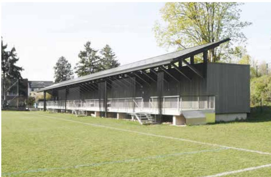
1 Die im Dach integrierten PV-Anlagen dienen nicht nur als emissionsfreie Energieversorgung mit einem Eigenenergiegrad von 97%, sondern vielmehr auch als Vordach für die Anlage.
