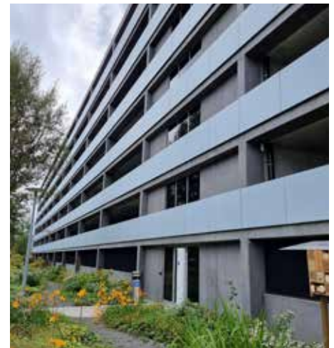
2 Die PV-Fassadenanlage generiert jährlich rund 68'200 kWh.
