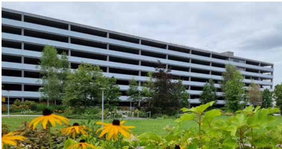
1 Das Parkhaus der Schindler Aufzüge AG verfügt über eine vollflächig fassadenintegrierte PV-Anlage mit einer installierten Leistung von 160kWp.
