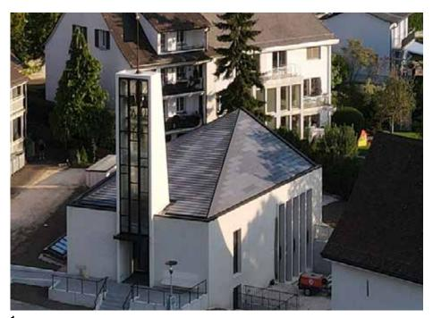
1 Die Evang.-Ref. Kirche Bettingen/BS weist eine teilweise integrierte PV-Dachanlage mit einer inst. Leistung von 20.6 kWp auf.
