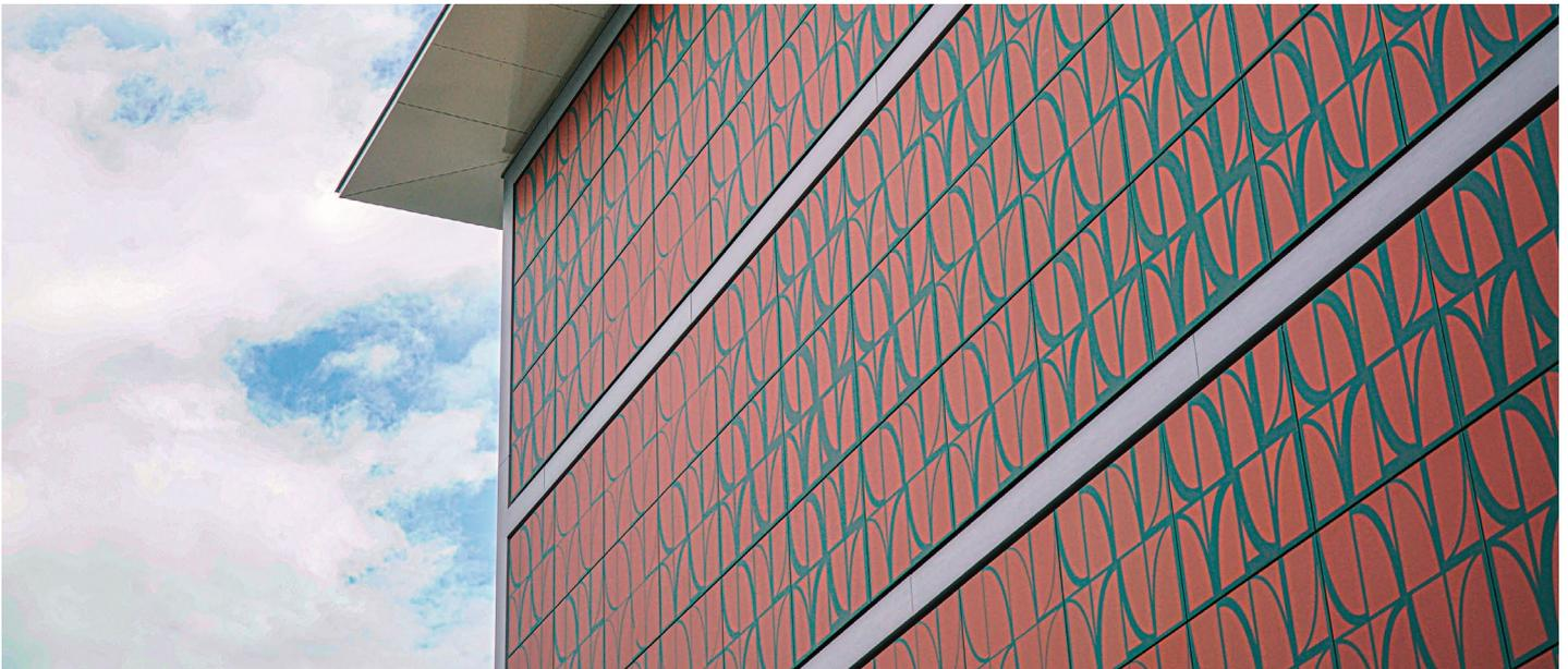
Innovative Kunst am Bau – in Zusammenarbeit mit der HSLU, Departement Design und Kunst, speziell bedruckte und sehr ästhetisch wirkende vorgehängte PV-Module
