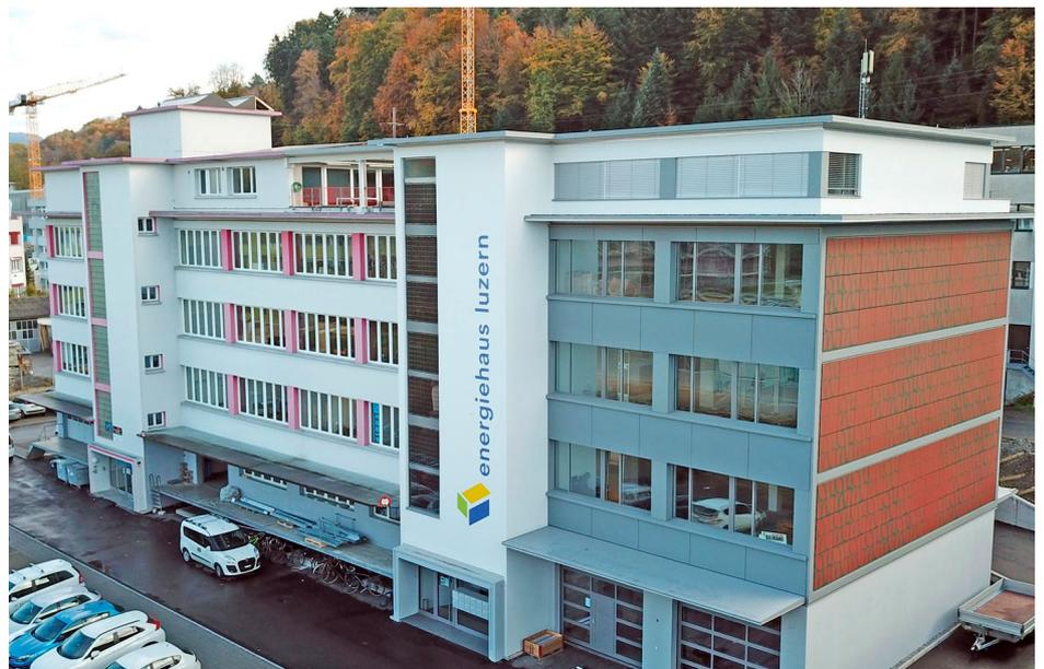
Architektonisch perfekt in den Bau integriert – vorgehängte, graue PV-Module
