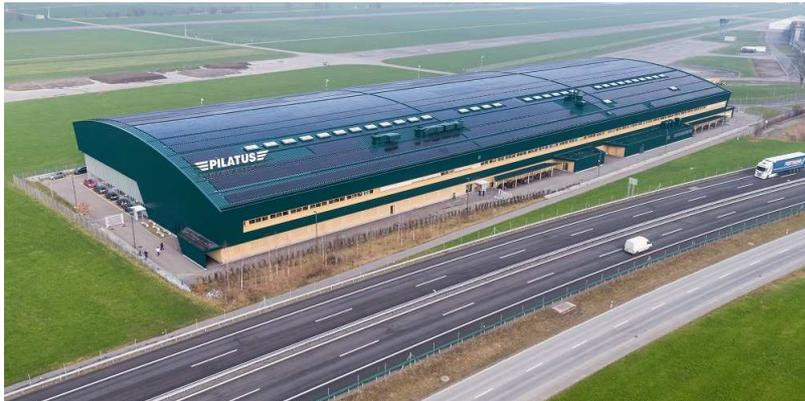
Bildlegende 1: *Knapp 5'000 Module wurden von BE Netz auf der neuen Holzhalle der Pilatus Flugzeugwerke installiert.*
