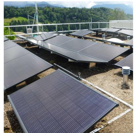
Auf dem Flachdach dieses Einfamilienhauses in Adligenswil plante und installierte BE Netz eine Photovoltaik-Anlage mit 35 monokristallinen Solarmodulen in Ost-West-Ausrichtung.
