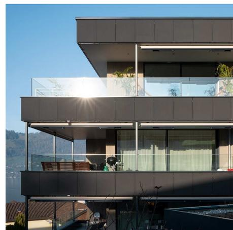
Die Bewohner des 3-FH mit Büro in Buochs profitieren rundum vom Sonnenstrom. An jeder Fassadenseite produzieren perfekt integrierte mattschwarze Module Solarstrom und auch auf dem Dach erzeugen Module erneuerbare Energie. Die Solarmodule auf dem Flachdach montierte BE Netz in Ost/West-Ausrichtung mit dem bewährten Montagesystem Formsol von PV-Integ.
