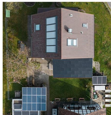
Rundum erneuerbar: Eine thermische Solaranlage mit Heizungs-Unterstützung der Luft-Wasser-Wärmepumpe und vier verschieden montierte Solarstrom-Anlagen versorgen dieses Einfamilienhaus mit sauberer Energie.
