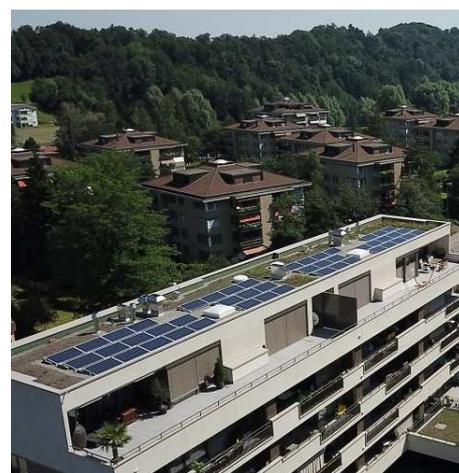
Auf zwei Gebäuden installierte BE Netz eine 23 kWp-Photovoltaik-Anlage. Die Anlage auf den Flachdächern umfasst je 47 poly- und 33 monokristalline Module mit einer Fläche von 130.6 m<sup>2</sup>. Die Module wurden mit dem Schweizer MSP-Montage-System montiert.
