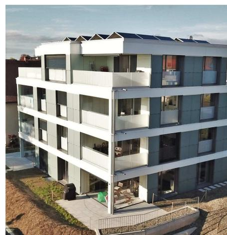
Dieses Mehrfamilienhaus wurde gleich rundum mit Solarmodulen eingepackt. Die Anlage auf dem Flachdach umfasst 61 Module à 335 Wp und 84 grüne Sonder-Module an der Fassade mit verschiedenen Leistungen zwischen 60 und 145 Wp. Zusammen ergeben sich 31.35 kWp.
