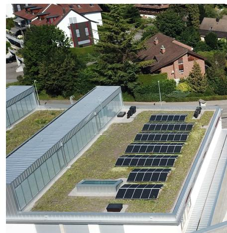
Auf der Schulanlage Staffeln in der Stadt Luzern installierte BE Netz eine 152.5 kWp-Photovoltaik-Anlage. Die Anlage ist auf zwei Gebäude verteilt, auf dem neuen Schulhaus beträgt die Leistung 123.22 kWp und auf der Turnhalle 29.28 kWp.
