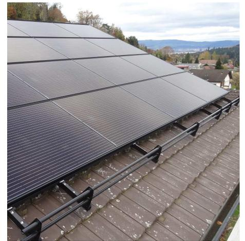
Das Einfamilienhaus dieser Familie ist eines wie jedes andere, jedoch nicht ganz - es produziert nämlich seine Energie selbst. Auf dem Dach ist eine 11.34 kWp-Photovoltaik-Anlage installiert. Die 36 Module à 315 Wp mit dem schwarzen Alurahmen bilden eine Fläche von 60 m<sup>2</sup>.
