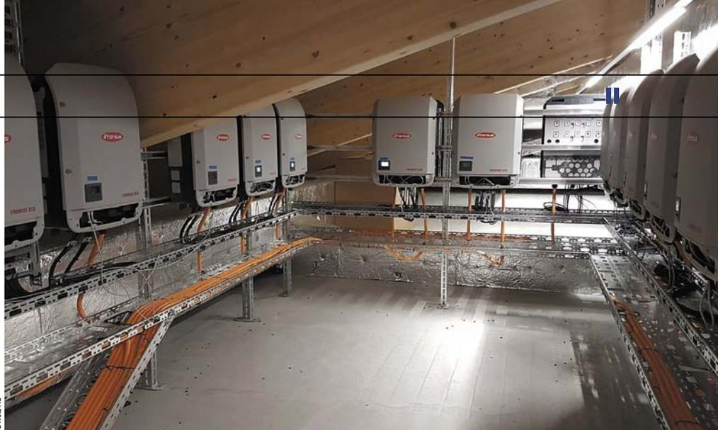
Die 34 Wechselrichter lieferte der österreichische Hersteller Fronius International AG. Sie wurden im Technikraum des Dachgeschosses installiert.
