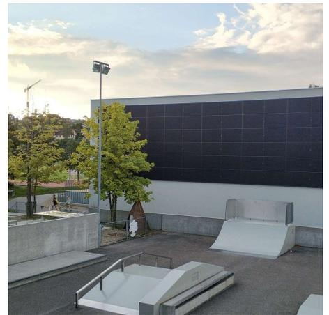
An der Fassade der Sporthalle Meggen installierte BE Netz im Auftrag der Gemeinde Meggen eine 33.5 kWp-Photovoltaik-anlage. Die 175.7 m<sup>2</sup> grosse Solarstrom-Anlage besteht aus 108 monokristallinen Modulen à 310 Wp und erzeugt ca. 24'000 kWh Energie pro Jahr.
