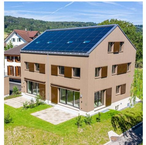
Auf dem Ensemble aus zwei Gebäuden installierte BE Netz je eine ins Dach integrierte Photovoltaikanlage. Auf dem Doppel-Einfamilienhaus ist eine 23.8 kWp installiert und auf dem Dreifamilienhaus eine 18.7 kWp-Solarstromanlage. Total ergibt sich eine Leistung von 42.5 kWp.
