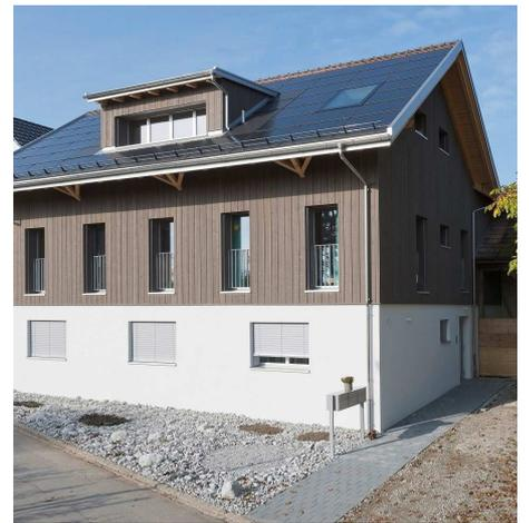
Die 16 kWp-Photovoltaikanlage auf dem Dach dieses Mehrfamilienhauses aus Massivholz erwirtschaftet weit mehr Energie als zum täglichen Bedarf der Bewohner notwendig wäre. Mit dem überschüssigen Strom kann die Anlage auch die Elektromobilität abdecken.
