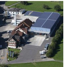
Ein ganz spezielles Photovoltaikprojekt realisierte BE Netz AG in Alpnach in enger Zusammenarbeit mit dem Elektrizitätswerk Obwalden (EWO), dem Besitzer der Anlagen, der Alpnach Sonnenstrom AG, sowie den Behörden. Auf mehreren Liegenschaften plante und installierte BE Netz 10 Solarstrom-Anlagen mit einer Leistung von über 1.5 MWp.
