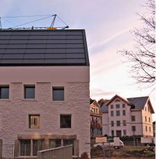
Die Photovoltaik-Anlage auf dem Geissmannhaus in Wohlen AG ist optimal und vorbildlich in das Dach integriert, alle Dachflächen sind mit Modulen belegt.
