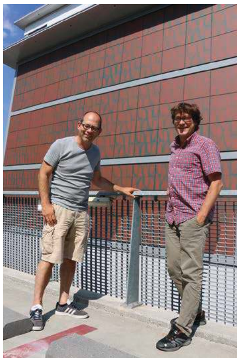
Sie blicken zuversichtlich in eine sonnige Zukunft: Adrian Kottmann (links) und Marius Fischer vor der Ostfassade ihres Energiehauses, das mit vertikalen Sonnenkollektoren bestückt ist.
