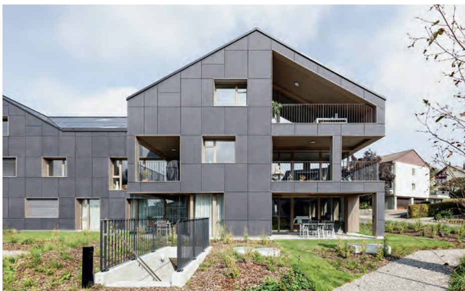
Das weltweit erste energieautarke Mehrfamilienhaus steht in Brütten: Seine Solarfassade ist nicht als solche erkennbar.
