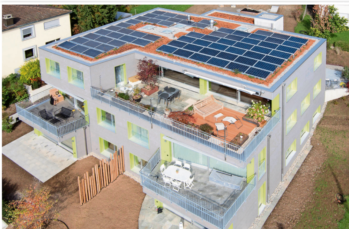
Mehrfamilienhaus mit einer Photovoltaik-Anlage.
