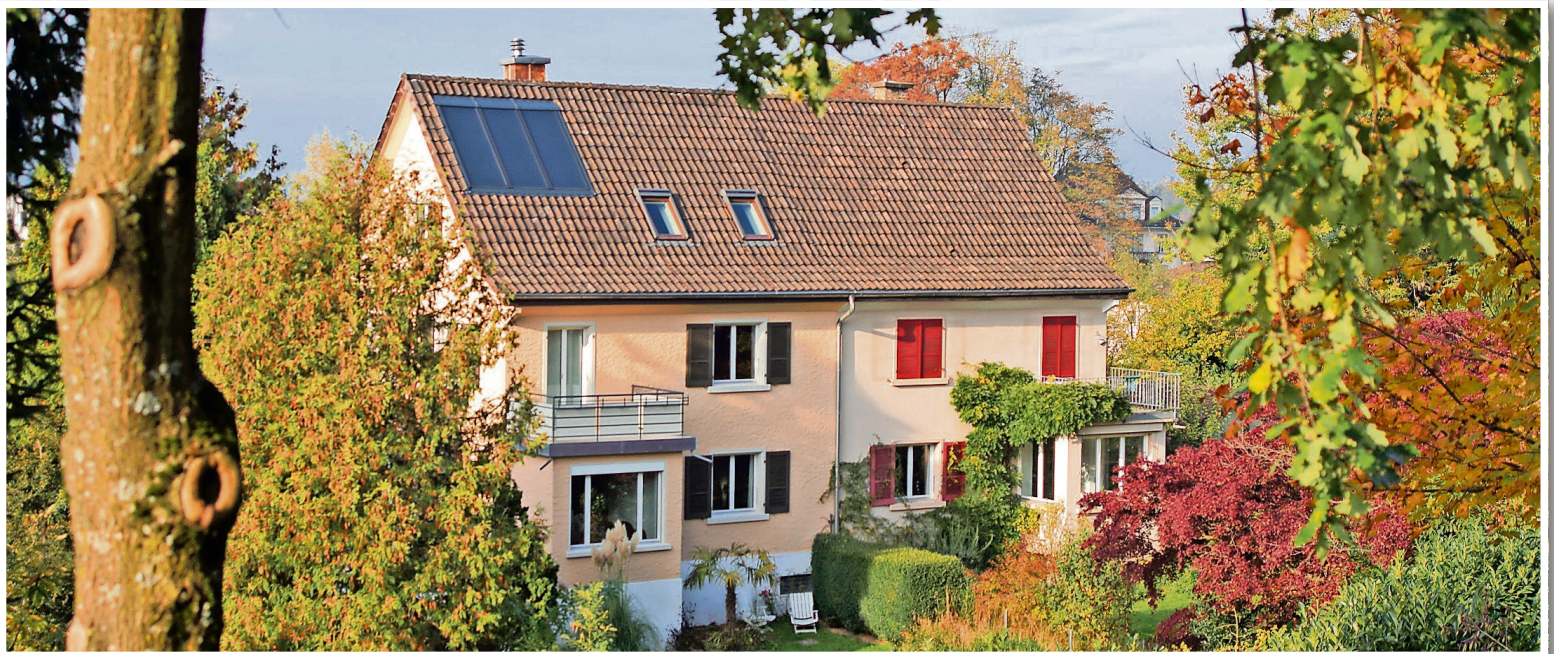
Einfamilienhaus mit integrierter Solarthermie.
