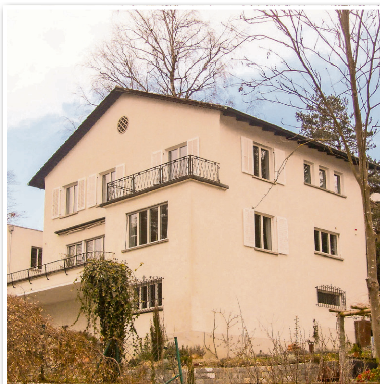
MFH vor energetischer Sanierung...
