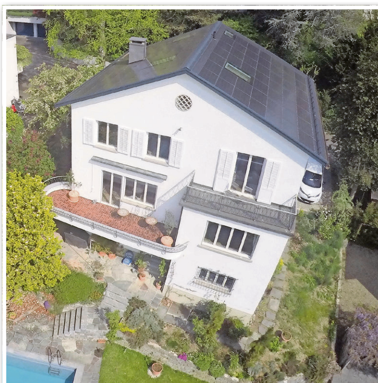
und danach mit integrierter Photovoltaik und thermischer Solaranlage.
