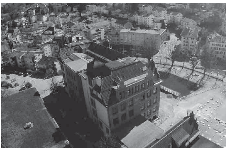
Das Maihofschulhaus aus der Luft. Die Solaranlage ist kaum zu erkennen.
