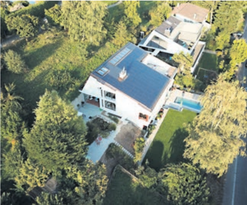
Überschüssiger Solarstrom kann an Nachbarn verkauft werden. Bild: BE Netz AG
