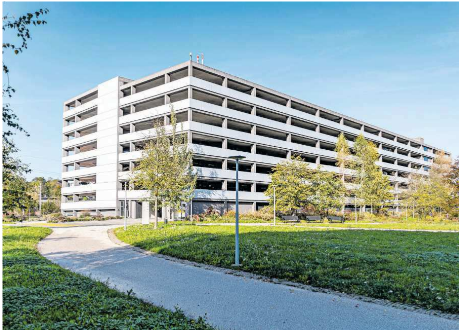
Gemäss Schindler «nicht brennbar»: Die weisse Photovoltaikanlage bedeckt alle vier Seiten des Parkhauses von Schindler.
