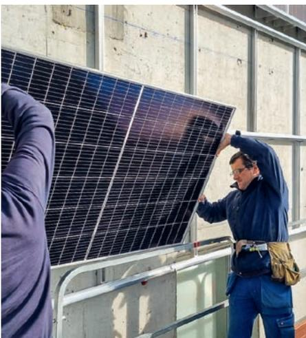
Herausfordernde Montagearbeiten in der Höhe. Auf der Mastkletterbühne wurden die Solarmodule zwischengelagert und für die Montage vorbereitet.
