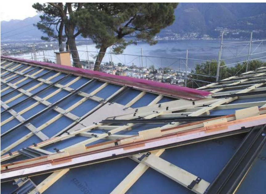
Montage-, Spenglerarbeiten und Dacheindeckung liefen Hand in Hand. Als Unterkonstruktion für die PV-Anlage wurde das System »Megaslate« von Meyer Burger verwendet.
