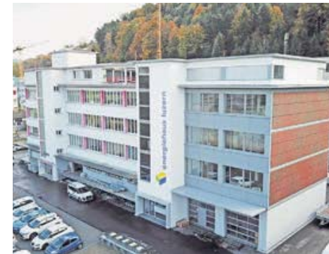
In Zusammenarbeit mit der Hochschule Luzern – Design & Kunst wurden für die Fassade (rechts) bedruckte Fotovoltaikmodule entwickelt. Bilder PD
