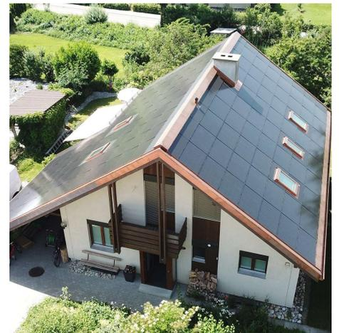
Beide Dachhälften dieses Einfamilienhauses wurden mit integrierten MegaSlate-Photovoltaik-Modulen eingedeckt. Die Anlage deckt mehr als den gesamten Bedarf der Bewohner. Der überschüssige Strom wird ins öffentliche Stromnetz eingespeisen.
