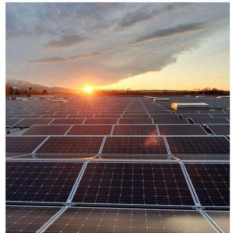
Auf dem Dach des ALDI SUISSE-Verteilzentrums in Perlen installierte BE Netz eine Photovoltaikanlage von 6.4 MWp, welche sauberen Strom für 2150 2-Personen-Haushalte produziert. Es ist der bisher grösste Auftrag für BE Netz seit Firmengründung.
