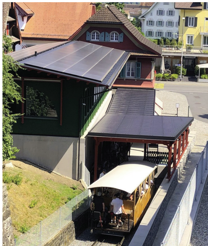
Abb. 4: Die PV-Anlage auf dem Perrondach wurde zusätzlich mit eigens angefertigten Blindmodulen ausgestattet, um eine denkmalpflegerisch und ästhetisch optimale Integration zu erreichen.
