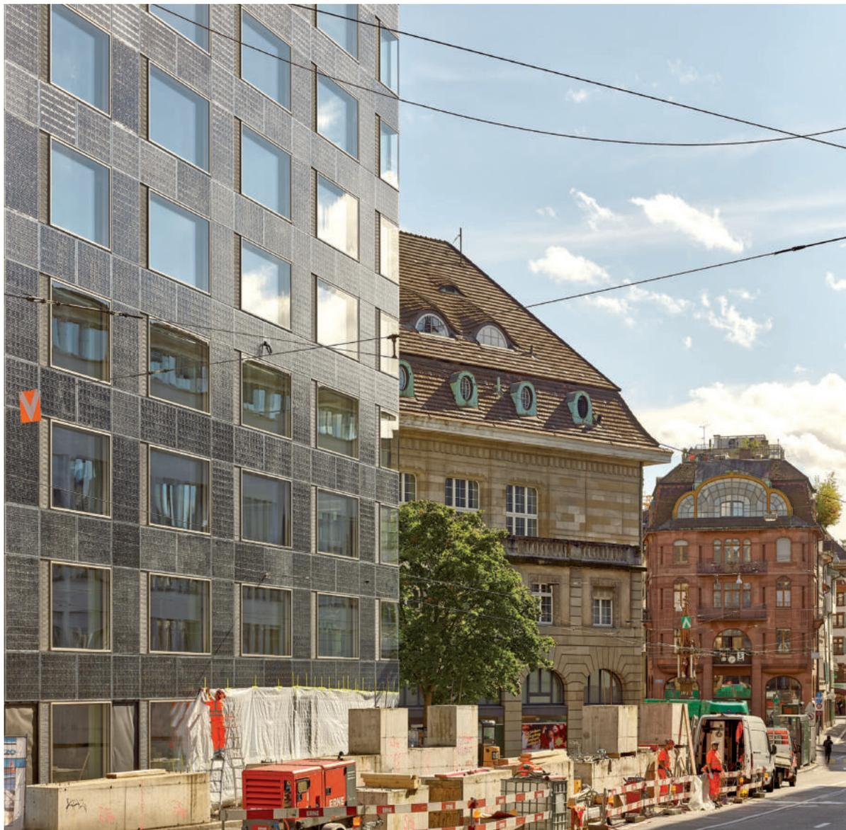
Insgesamt 800 individuelle Fassadenmodule mit Fotovoltaikzellen komplementieren die Aussenhülle des Neubaus und sorgen für eine Stromerzeugung in allen Himmelsrichtungen.
