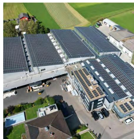
Meyer BlechTechnik AG ist ein führender Blechbearbeitungsbetrieb in der Schweiz. Zur Unterstützung der Stromerzeugung für die Metallverarbeitung installierte BE Netz eine Photovoltaik-Anlage mit 835 kWp und einer Fläche von rund 4093 m<sup>2</sup>. Insgesamt wurden 2163 Solar-Module verbaut.
