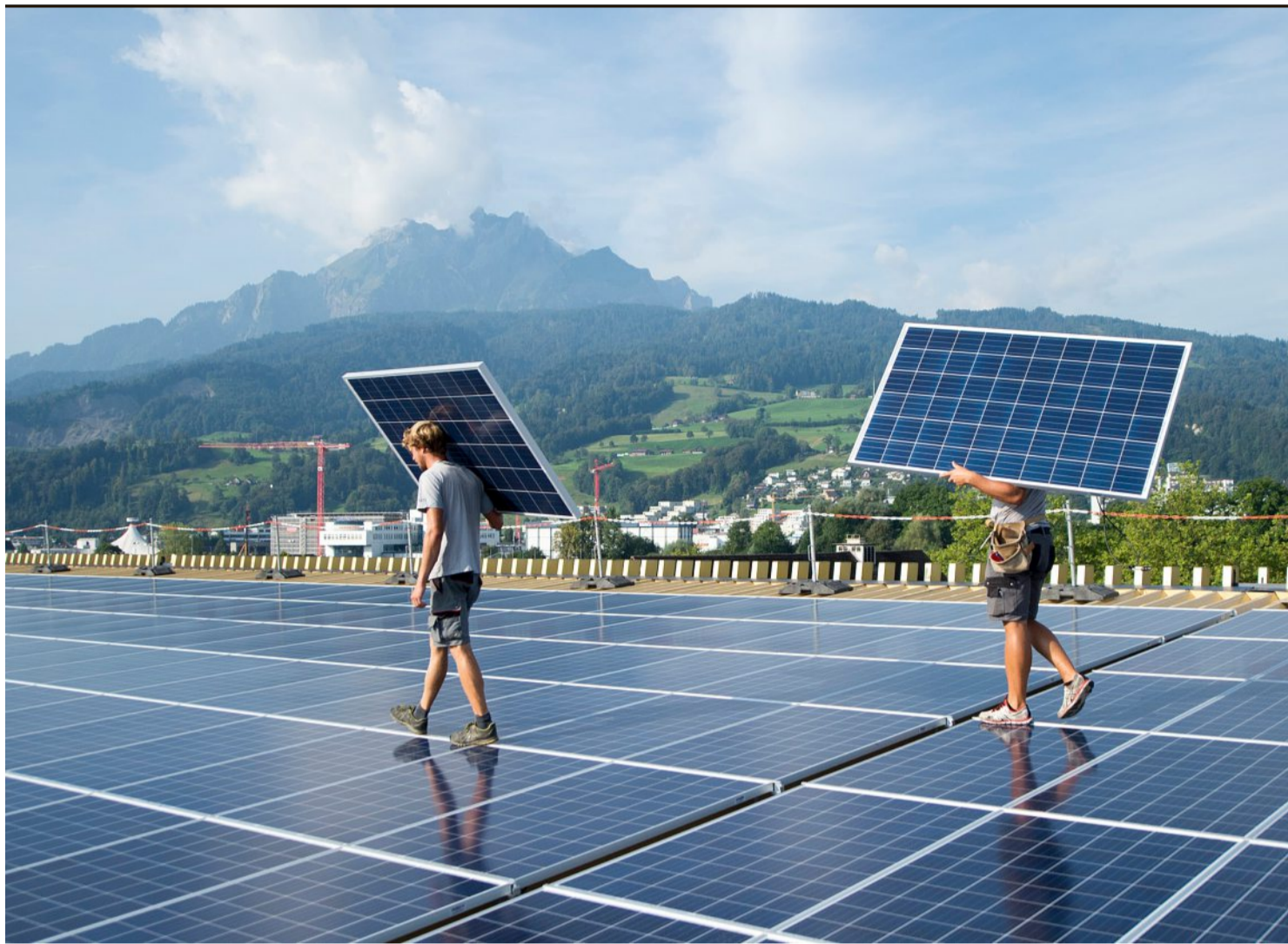
Gefragte Spezialisten: Auf dem Dach der Swisspor-Arena in Luzern wird eine Fotovoltaikanlage montiert. Foto:Urs Flüeler (Keystone)
