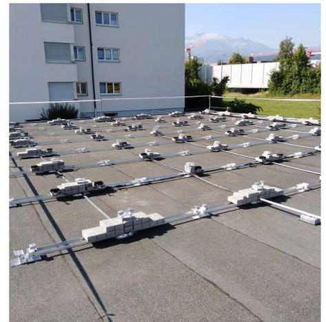
Dank einem anstehenden Heizungersatz im MFH an der Lindenheimstrasse in Emmen, werden nun die fossilen Energieträger durch 25 m<sup>2</sup> Sonnenkollektoren und der Strombezug durch eine 27.5 kWp starke Photovoltaikanlage unterstützt.
