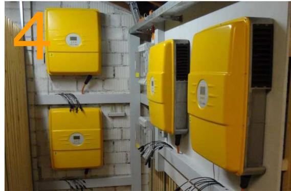
4 / 4 SolarMax-Wechselrichter des Typs 15 MT2 an der Magdenstrasse, Basel
