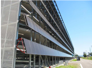
Rot markiert die Konsole, auf der das Einlegeprofil angebracht wurde. Weitere Erklärung siehe Textende rechts. Bild: BE Netz
