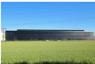
Dem Bundesamt für Strassen ASTRA musste die Befürchtung bezüglich störender Blendungen auf die Verkehrsteilnehmer auf der angrenzenden Autobahn widerlegt werden. ©Bild: BE Netz
