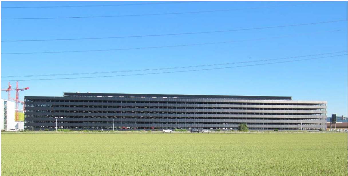
Bildlegende Abb2: Solare Fassade, F. Hoffmann-La Roche in Kaiseraugst mit 404 kWp
