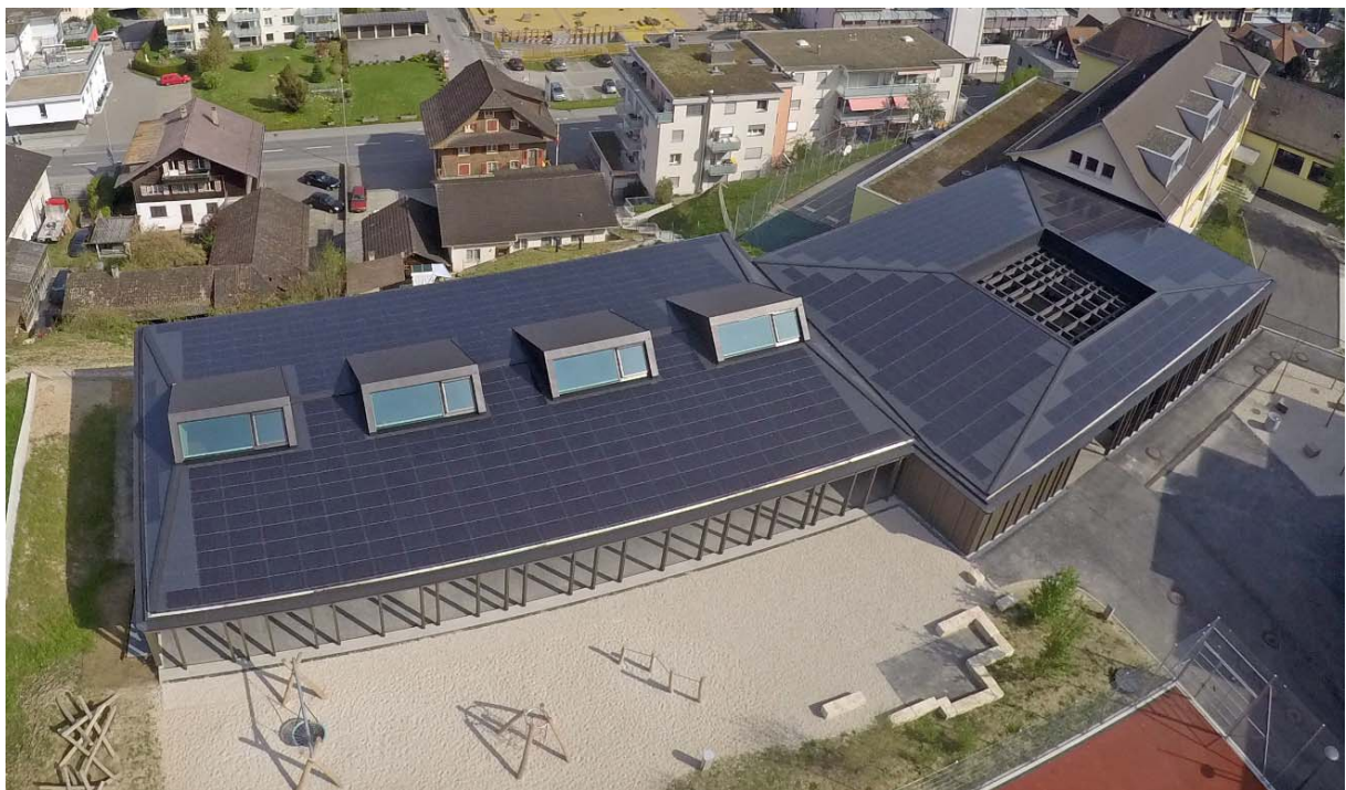
Bildlegende Abb1: Integrierte Photovoltaik-Anlage, Schulanlage Bündtmättli in Malters
