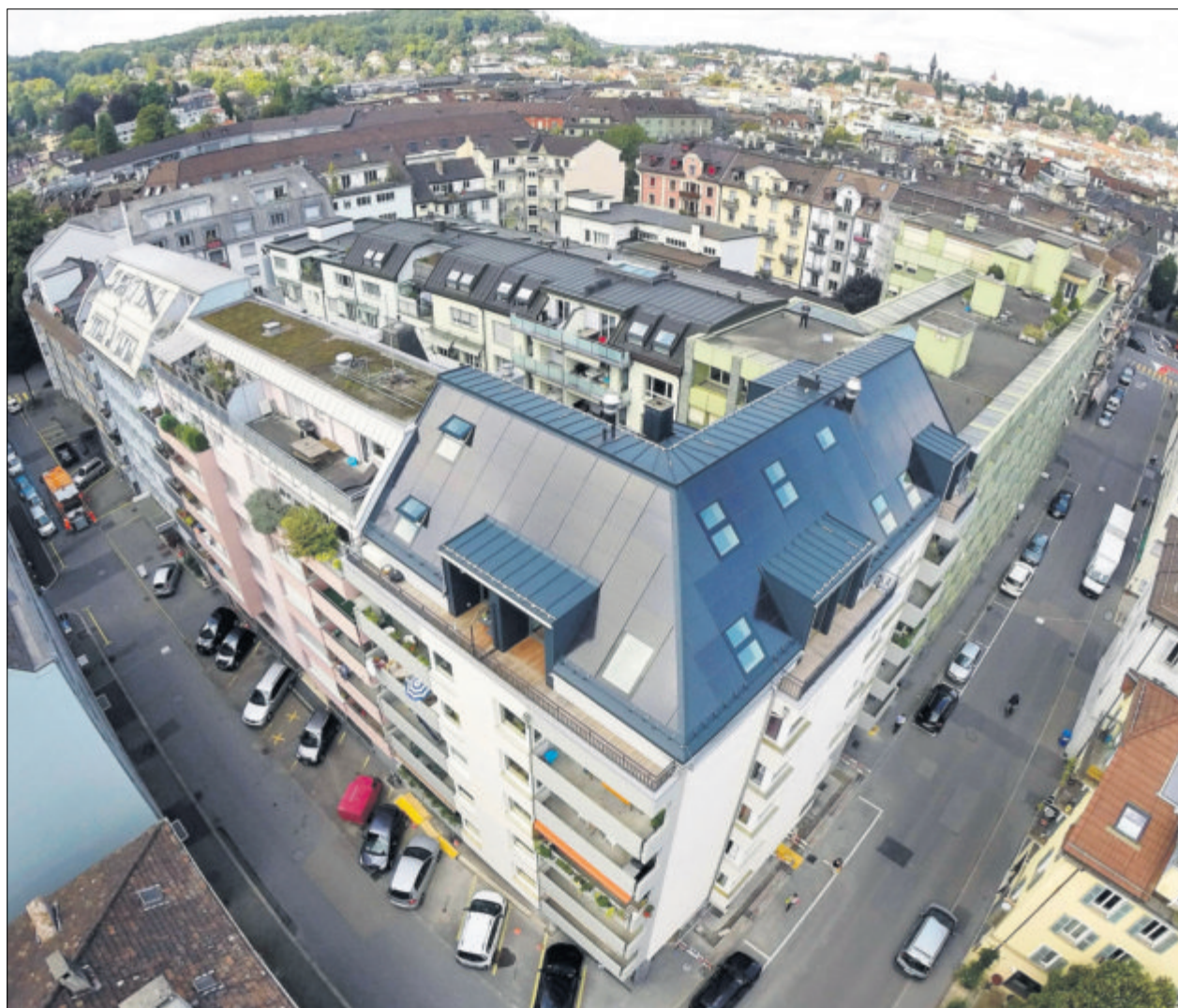
26 Fenster gibt es zwischen den Solarpanels auf dem Dach des Stadtluzerner Mehrfamilienhauses an der Ecke Neustadtstrasse (rechts) und Neuweg.
